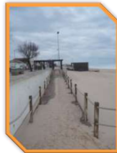
Rampas de acesso ao areal
