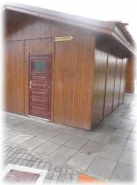
Existe WC sem sinalização.
