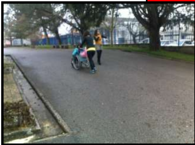
Rampas com extrema inclinação
