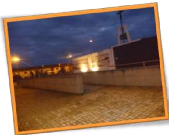
Rampa de acesso à capela
